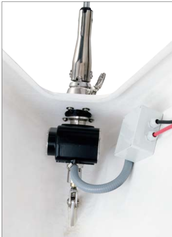
Genomgående installation av Furlex 200E. Kopplingsboxen är vattentät.
